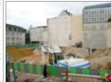
C'est à cet endroit, entre le bâtiment des Urgences et le centre de radiothérapie, que s'est ouvert le chantier de la future clinique.
