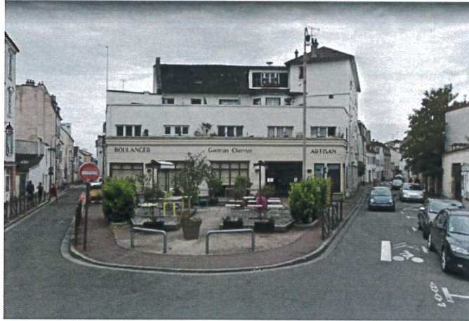
1-Vue de l'angle formé par la rue de la Grande Fontaine et la rue Wauthier
