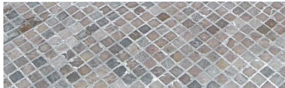
Place : pavés en grès des Indes de couleur pastel nuancé gris-rose-vert-bleu, dimension 15x15 cm posé à 45°
