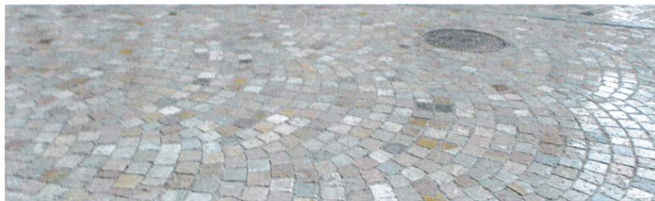
Bande roulante : pavés en grès des Indes de couleur pastel nuancé gris-rose-vert-bleu, dimension 10x10 cm posé en arc de cercle.
