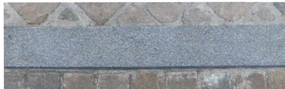
Bordures : Granit de couleur gris – ocre de largeur 15cm, avec chanfrein à 45° (réf NG Real)
