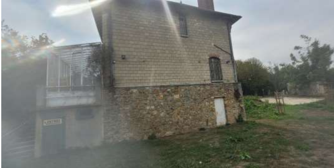
Façade côté usine
